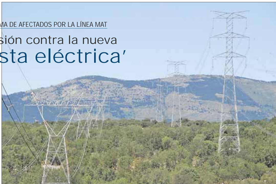
La nueva línea de muy alta tensión transcurre al lado de las antiguas torres. (Vista desde Alpedrete)
