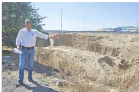
El portavoz socialista frente a las obras del nuevo Centro Comercial
