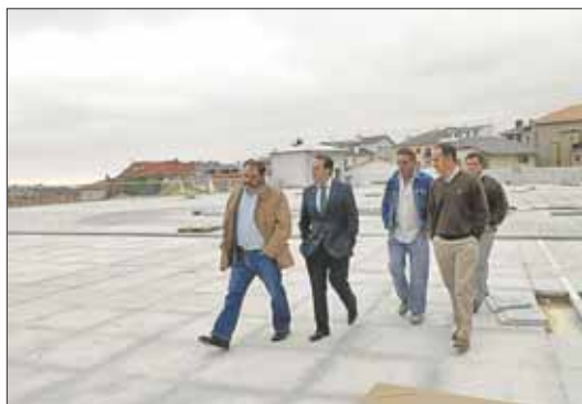
Eugenio Romero y Jaime González Taboada en la visita a las obras
